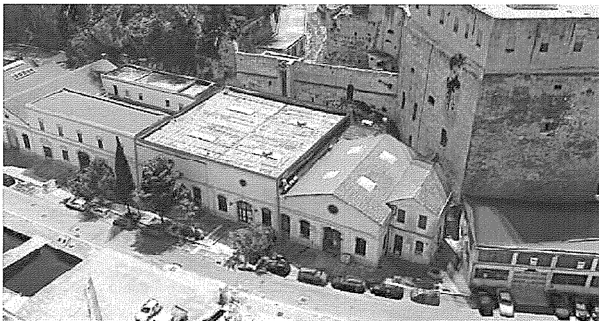
Figura nr. 2 – Ortofoto prospettica – Centrale elettrica
